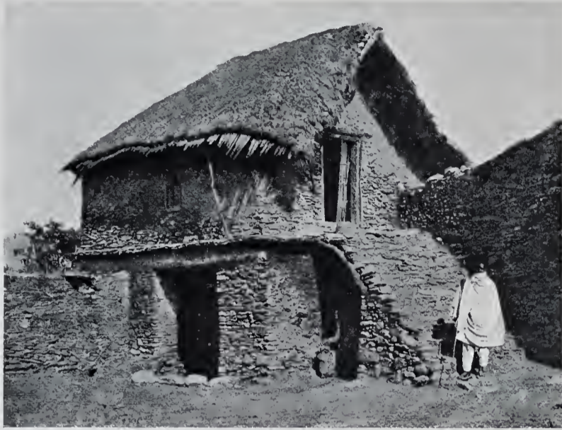
Abb. 98. Hofansicht des Torhauses in Abb. 97. Adua.
